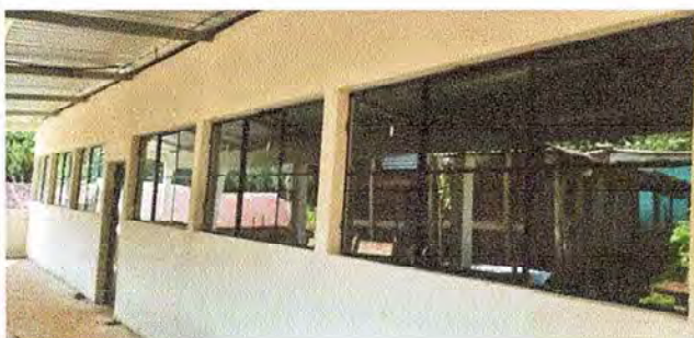
Foto 4: Instalación de ventanales de metal con su respectivo vidrio mejorando la claridad y ventilación.
