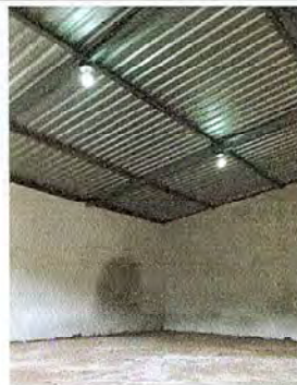
Foto 8: Mejoramiento de pared formal a base de block con su respectivo repello.
