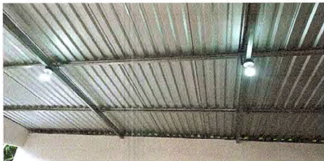
Foto 7: Mejoramiento de sistema eléctrico principal con sus respectivos apagadores, tomacorrientes y lámparas.
