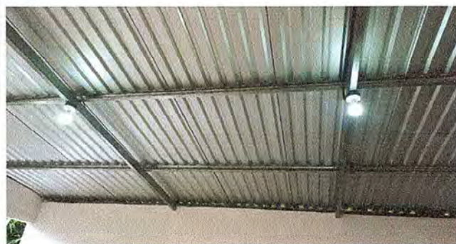
Foto 2: Instalación de estructura de metal para mejorar las condiciones de soporte de cubierta.
